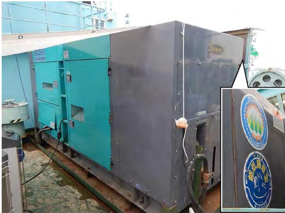
写真5-1 超低騒音型、排出ガス対策型建設機械の使用状況（発電機）
