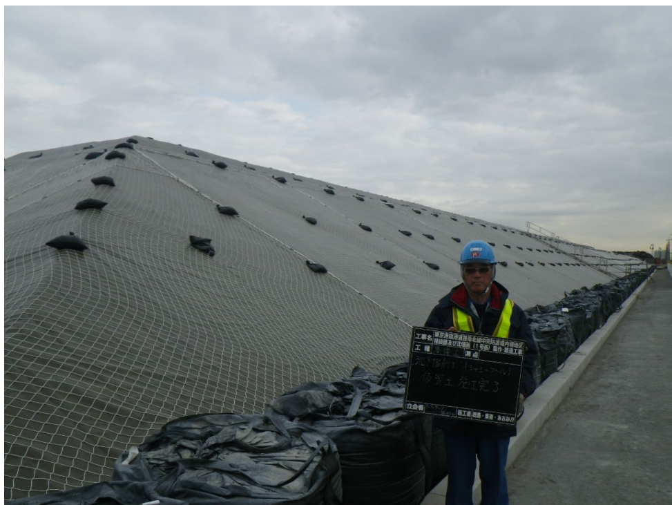
写真4-1 建設発生土の仮置き状況
