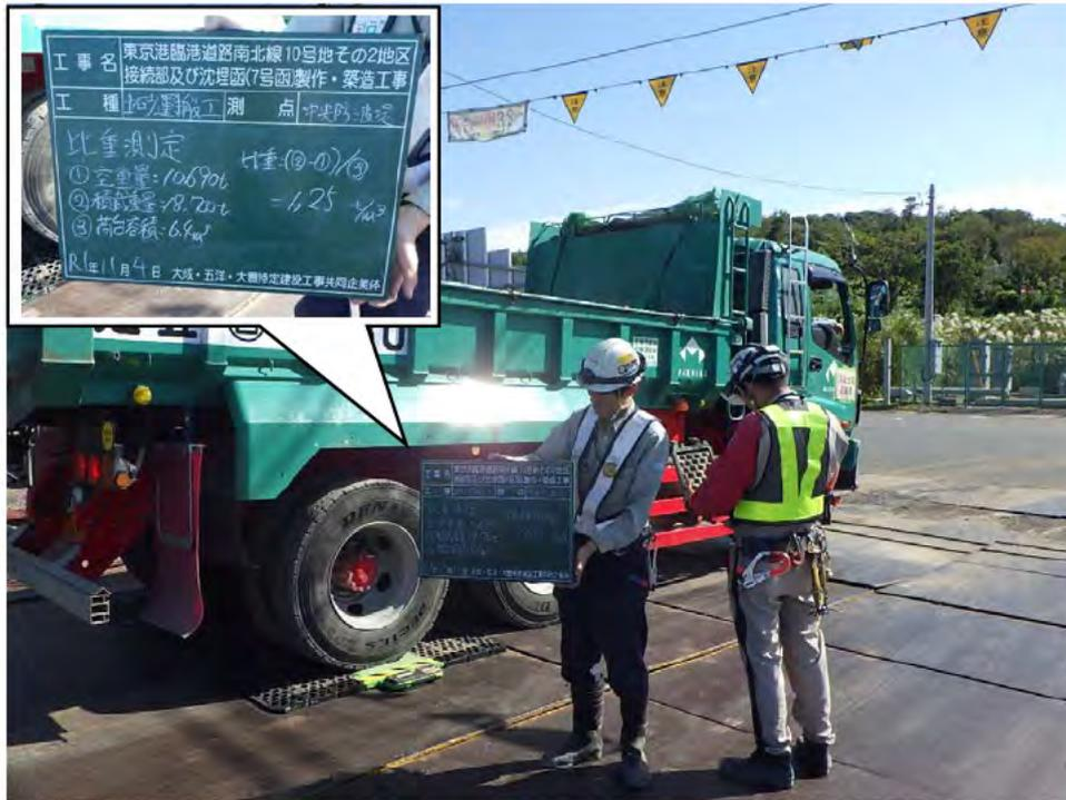
写真1-3(2) 過積載防止教育（トラックスケール計測状況）
