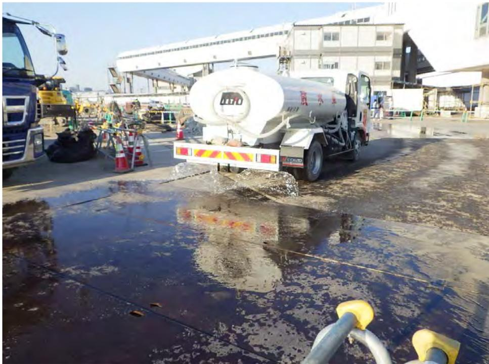
写真1-4 散水車による散水
