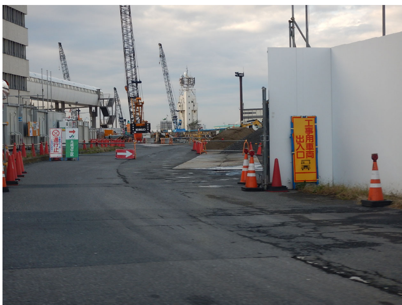
写真3.2-3 環境保全措置の実施状況（防音パネルの設置）
