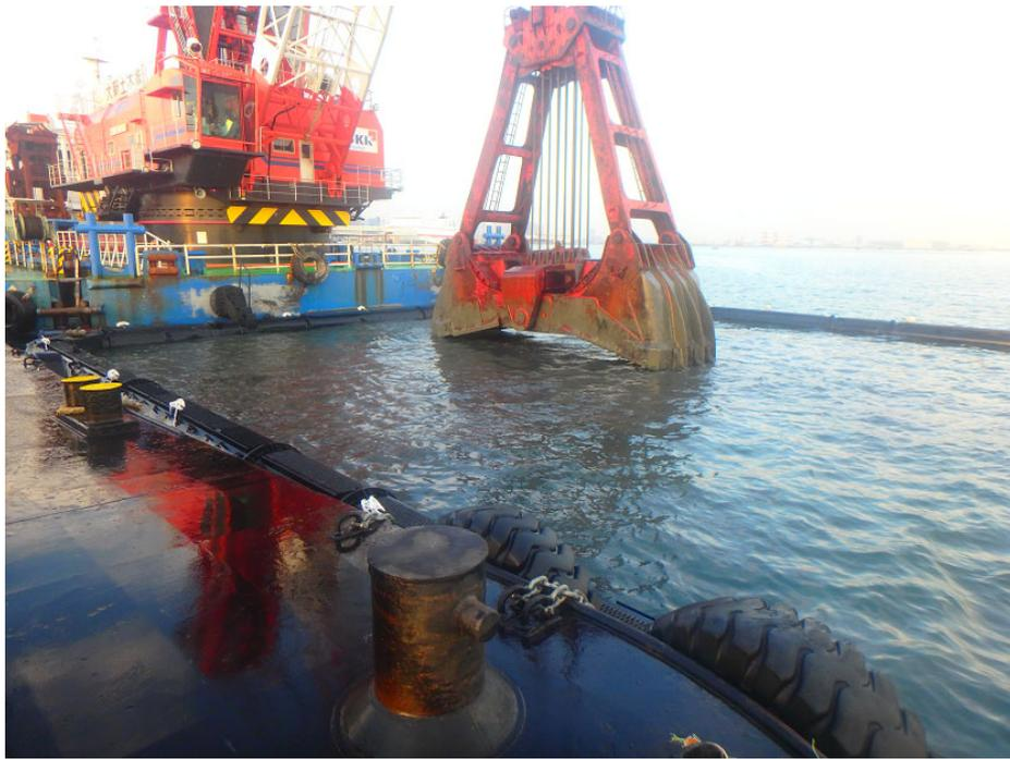
写真6-3 汚濁防止枠・密閉式グラブの使用状況
