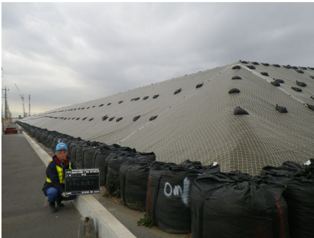
写真5-1 建設発生土の仮置き状況
