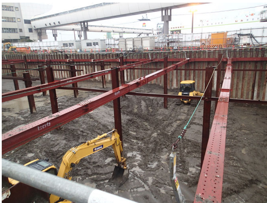
写真3-2 連続地中壁の状況
