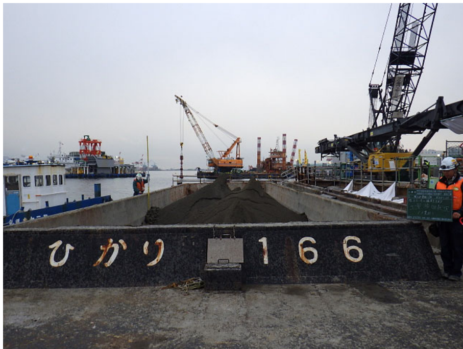
写真3-1 汚染土壌の運搬
