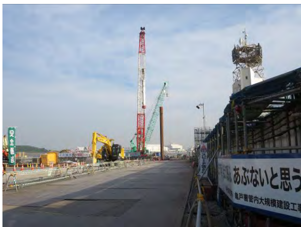
油圧パイルハンマ設置
