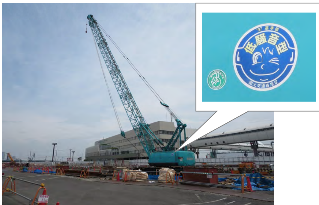
写真2-3 低騒音型クローラクレーンの使用状況
