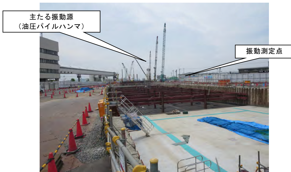
写真2-6 建設作業振動測定時の状況
