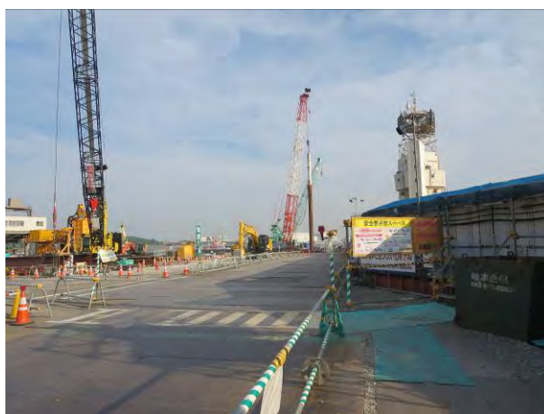
油圧パイルハンマ稼働中
