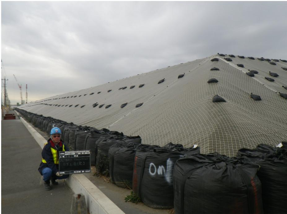
写真1-2 残土飛散防止シートの敷設
