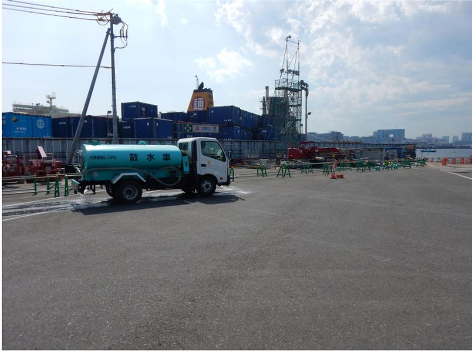
写真1-1 散水車による散水
