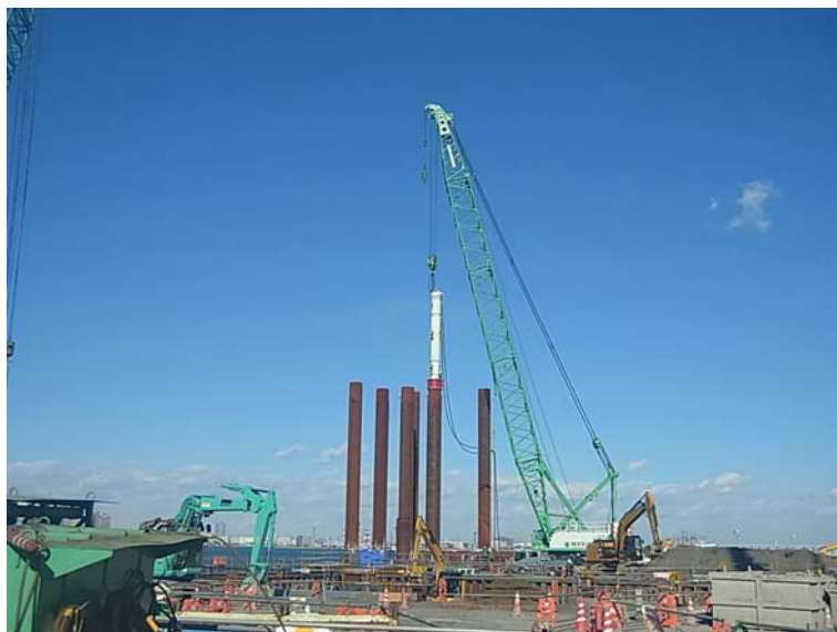
写真2.1-1 工事の施工状況（油圧パイルハンマによる鋼管杭打設工）
