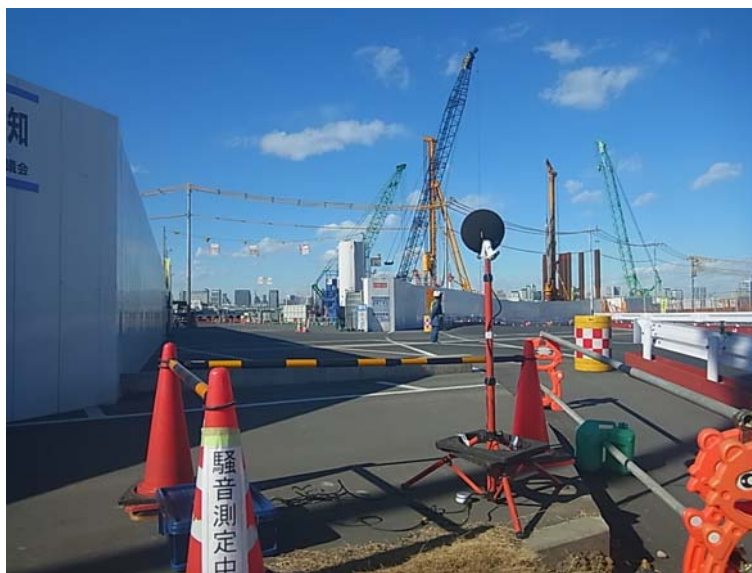
写真2.1-2 環境保全措置の実施状況（防音パネルの設置）
