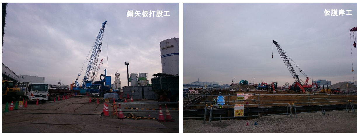
写真1.2-4 工事の施行状況（鋼矢板打設工、仮護岸工）
