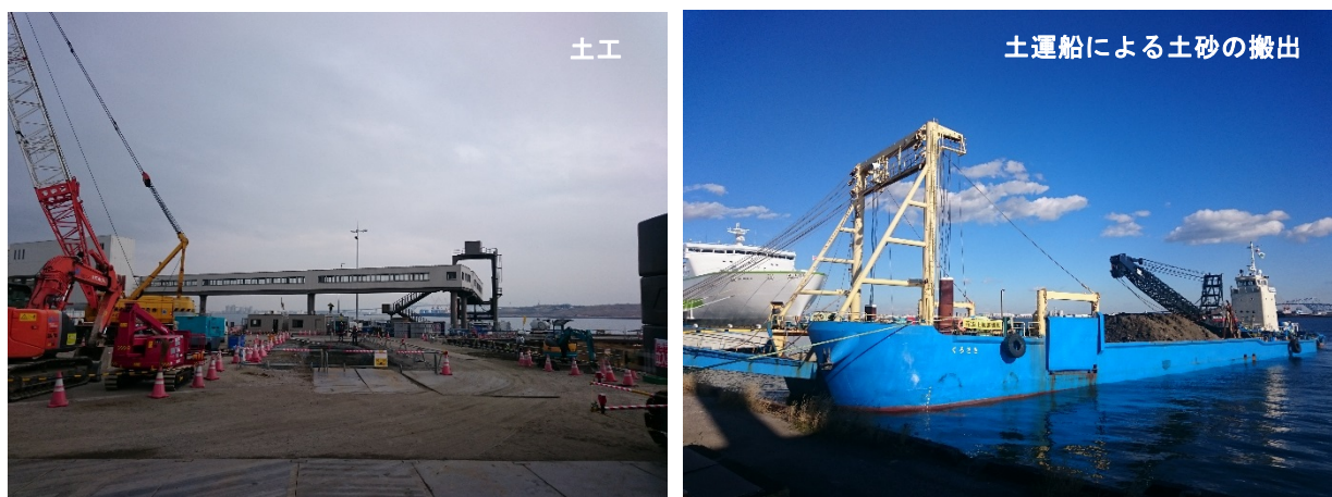
写真1.2-5 工事の施行状況（土工、土運船による土砂の搬出）
