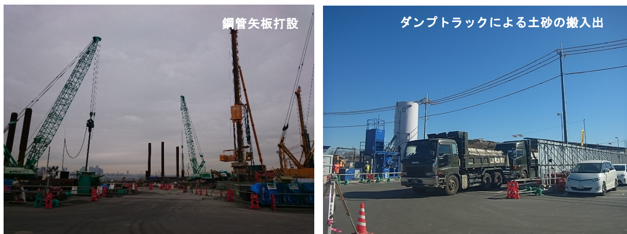
写真1.2-6 工事の施行状況（鋼管矢板打設工、ダンプトラックによる土砂の搬入出）
