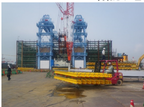
写真1.2-10 工事の施行状況 (接続部工)
