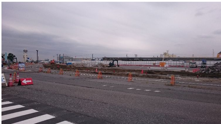
写真1.2-1 工事の施行状況（既設工作物撤去工）
