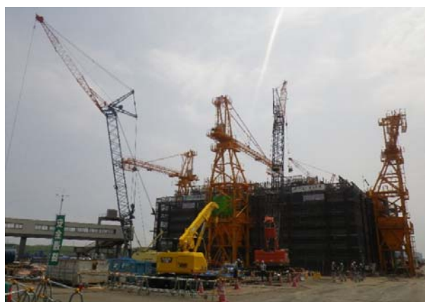
写真1.2-9 工事の施行状況 (接続部工)
