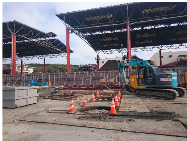
写真1.2-3 工事の施行状況 （既設構造物撤去工）
