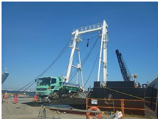
写真1.2-7 工事の施行状況 (ダンプトラックによる土砂の運搬)
