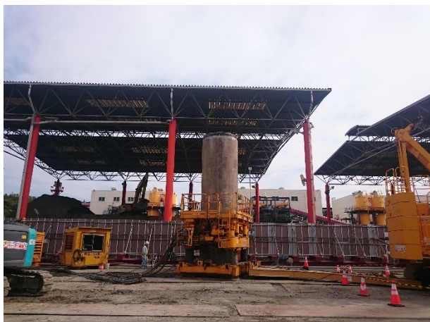
写真1.2-2 工事の施行状況（地盤改良工）
