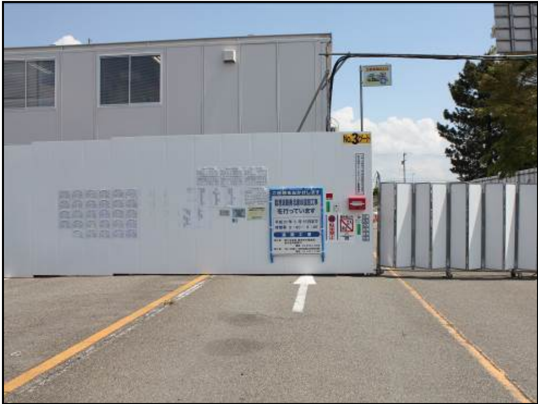
写真7-4 計画道路部の遮音壁と残存植栽
