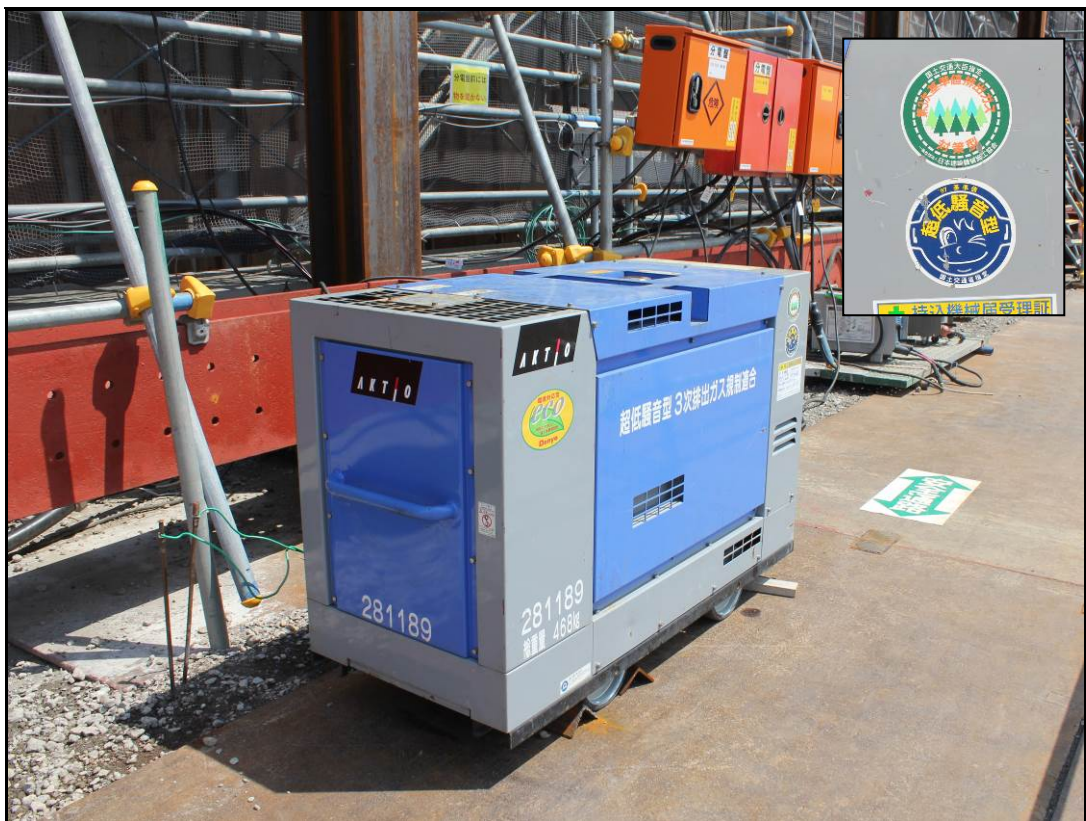
写真7-5 低排出・超低騒音型発電機の使用
