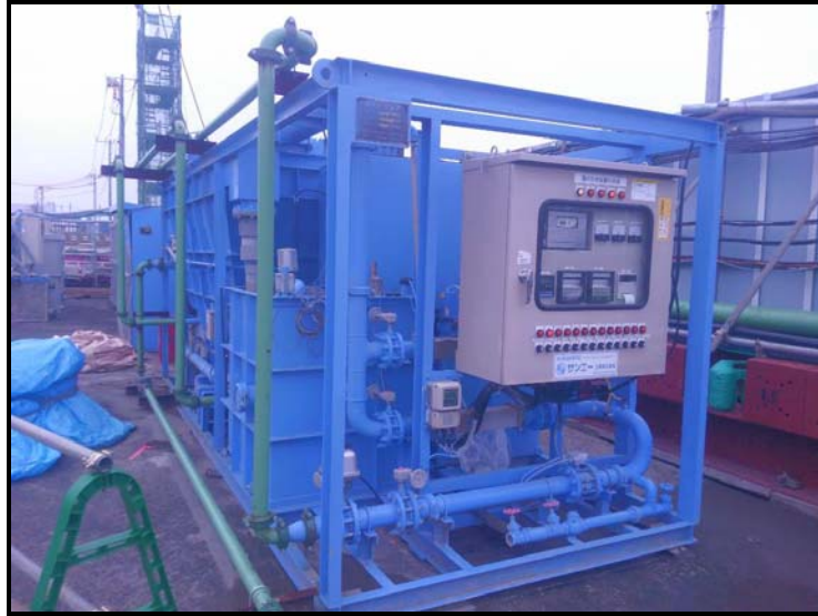
写真7-6 濁水処理の実施
