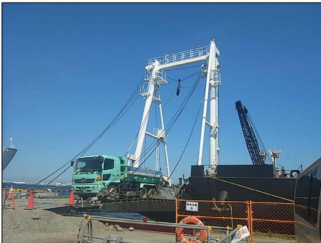
写真4-1 土砂運搬の状況
