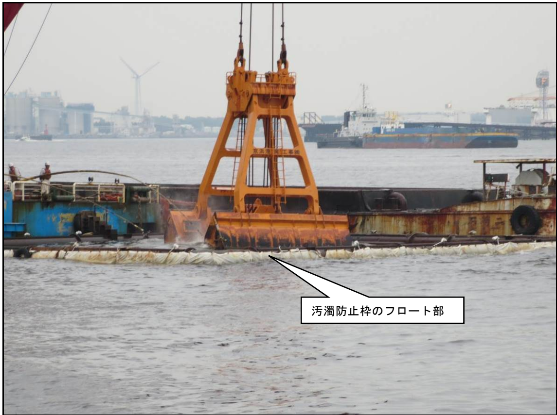
写真3-1 汚濁防止枠の使用
