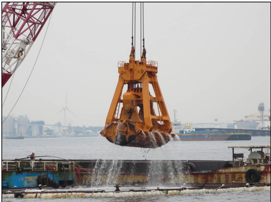
写真3-2 密閉式グラブの使用
