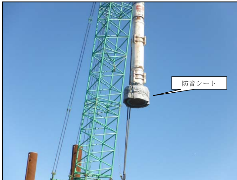
写真2-3 追加の環境保全措置の実施状況（防音シートの設置）
