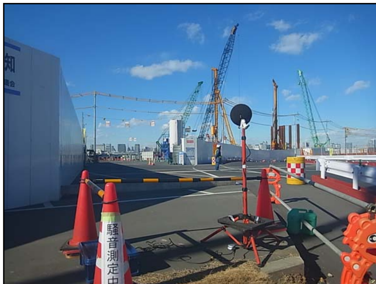
写真2-2 環境保全措置の実施状況 (仮囲いの設置)
