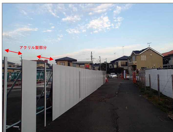
写真 3-3 仮囲いの設置状況
