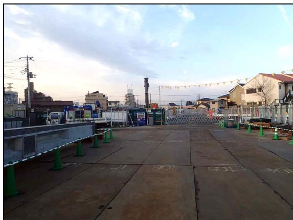
写真 3-1 施工ヤード内の敷き鉄板の敷設
