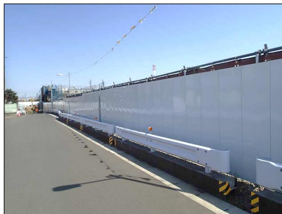
写真 3-2 仮囲いの設置状況
