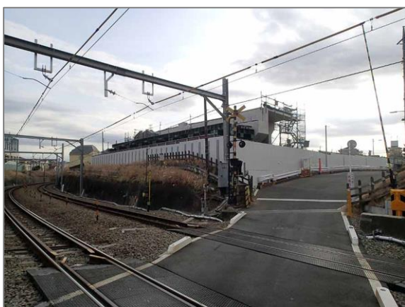
写真 1-2 仮囲いの設置状況
