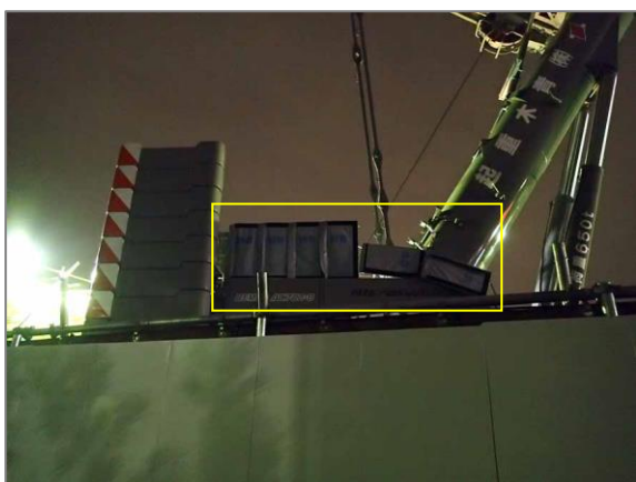
写真 1-4 クレーン音源部の防音シート設置
