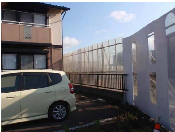
写真 1-4 仮囲いの設置状況
