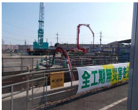
写真 1-1 (3) 調査地点現況写真 (調査地点 No. 3 : 擁壁工)
