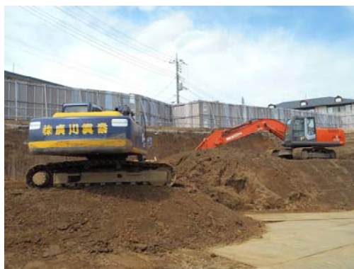
写真 1-1 (5) 調査地点現況写真 (調査地点 No. 5 : 山留め掘削工)
