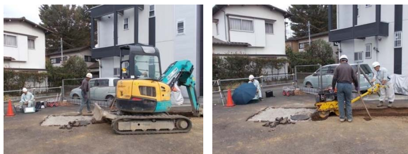
写真 1-1(1) 調査地点現況写真 (調査地点 No.1 : 土工・街築工)
