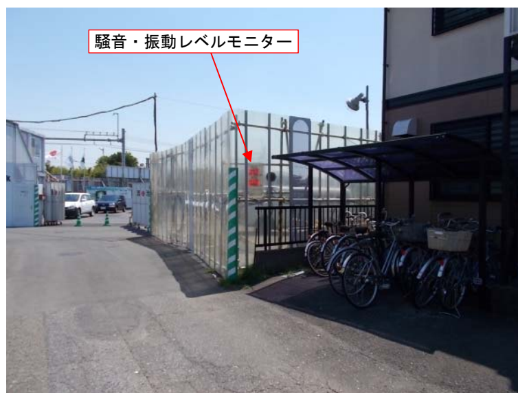
写真 1-7 騒音・振動レベルモニターの設置状況（アンダーパス部）
