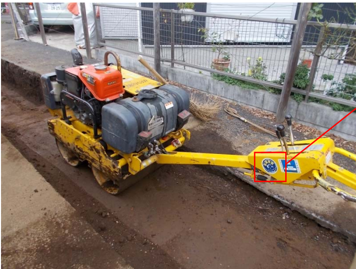
写真 1-2(4) 低騒音型建設機械の使用状況（ハンドガイドローラ）（平面部）
