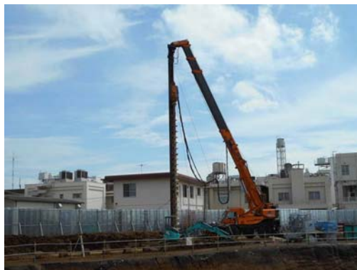
写真 1-1 (4) 調査地点現況写真（調査地点 No. 4：山留め掘削工）
