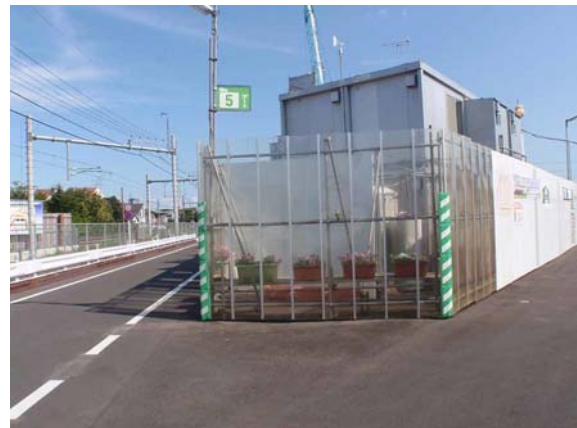
写真 1-4 仮囲いの設置状況
