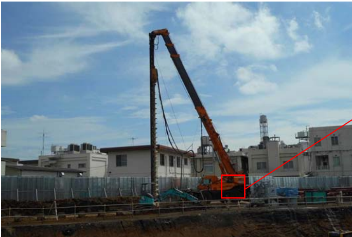
写真 1-2(3) 低騒音型建設機械の使用状況（杭打機）（アンダーパス部）
