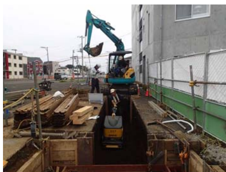
写真 1-1 (2) 調査地点現況写真（調査地点 No. 2：土工・街築工）
