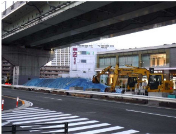
写真 4-1 環境保全のための措置の実施状況（飛散防止シートの装着）
