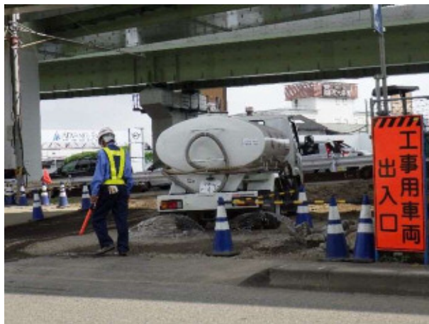
写真 4-2 環境保全のための措置の実施状況（散水の実施）
