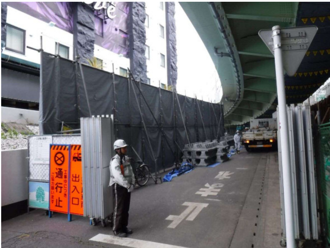
写真 2-2(4) 環境保全措置の実施状況（騒音対策）
