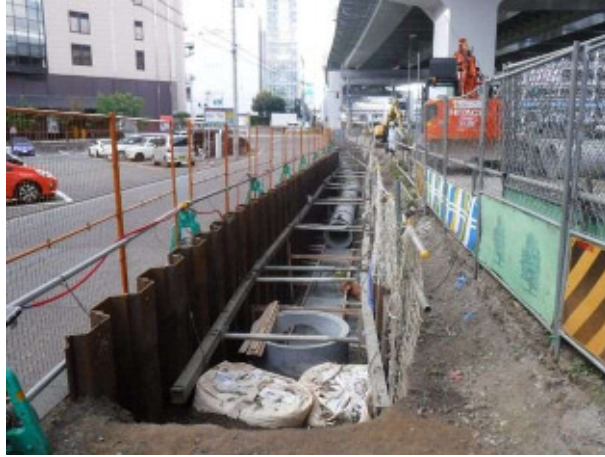
写真 4-4 環境保全のための措置の実施状況（鋼矢板工法の採用）
