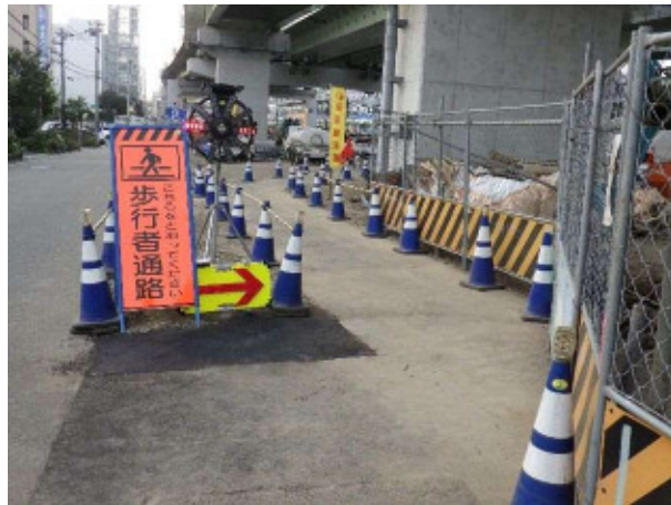
写真 4-5 環境保全のための措置の実施状況（仮設切り回し歩道の設置）
