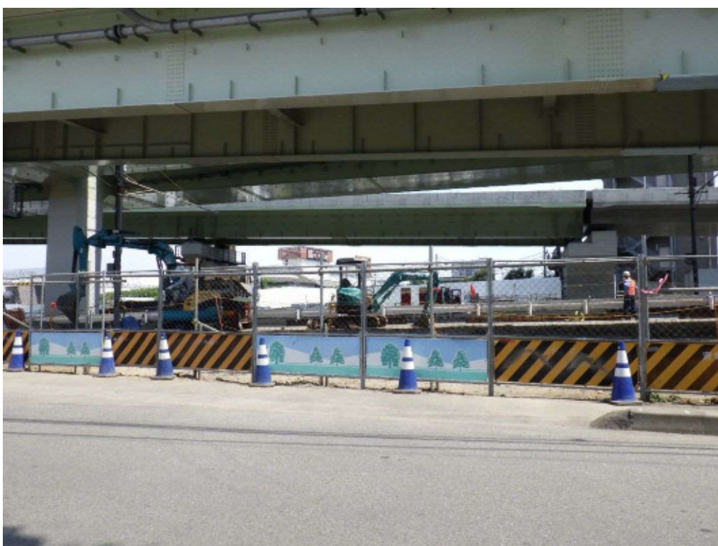
写真 2-1(2) No. 1 : 掘削工事の状況(令和2年8月7日撮影)
