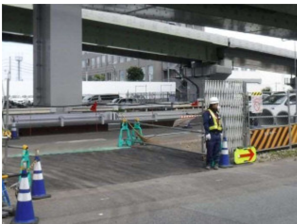
写真 4-6 環境保全のための措置の実施状況（交通監視員の配置）
