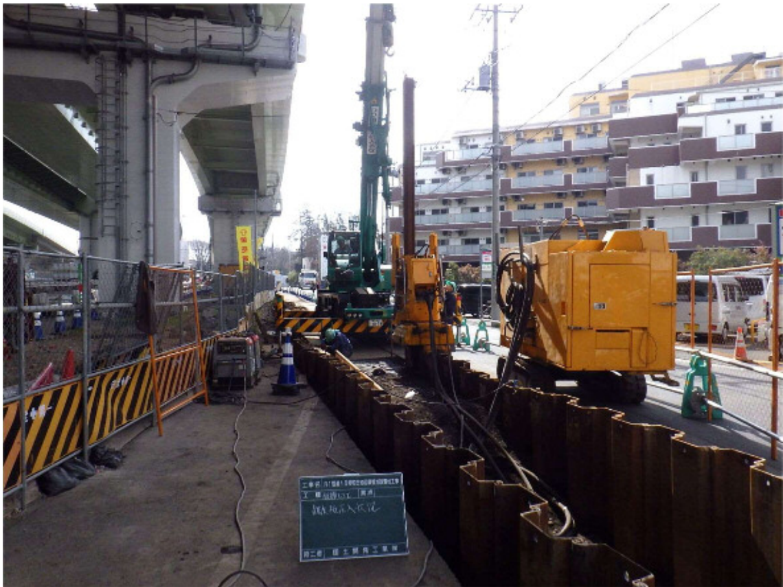
写真 2-2(1) 環境保全措置の実施状況（騒音・振動の発生が少ない工法の採用）
