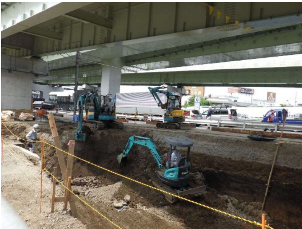
写真 2-1(1) No. 1 : 掘削工事の状況(令和2年8月7日撮影)
