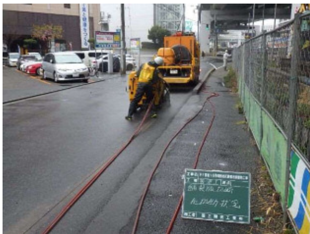
写真 4-3 環境保全のための措置の実施状況（舗装版のカッターによる濁水の回収）
