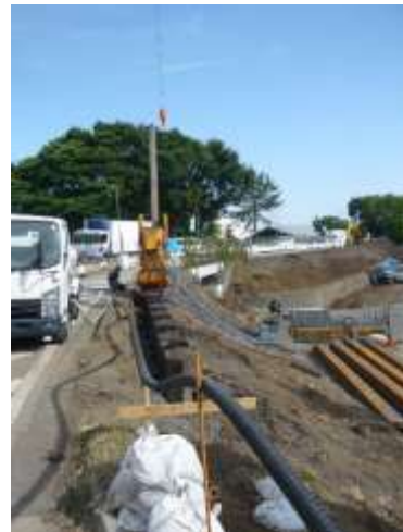
写真 2-2(4) 環境保全措置の実施状況（騒音・振動の発生が少ない工法の採用）
