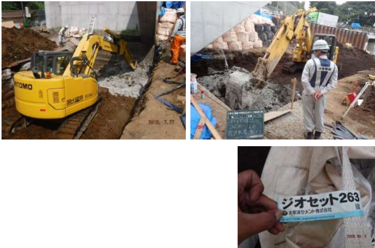
写真 4-2 環境保全のための措置の実施状況（粉塵抑制型地盤改良材）
