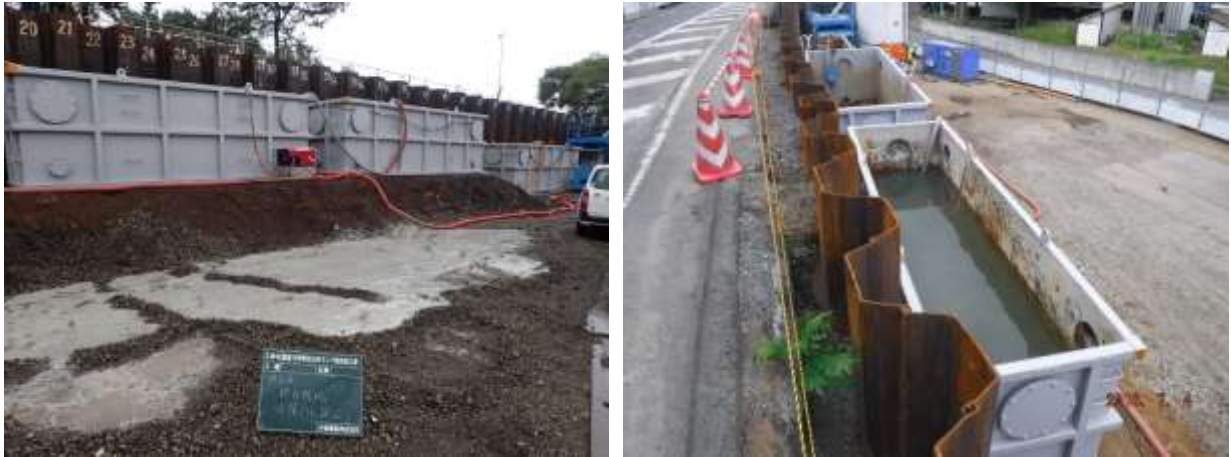
写真 4-6 環境保全のための措置の実施状況（移動式沈殿槽）
