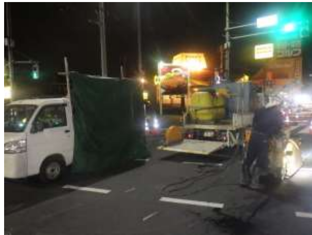
写真 4-7 環境保全のための措置の実施状況（舗装版のカッターによる濁水の回収）
