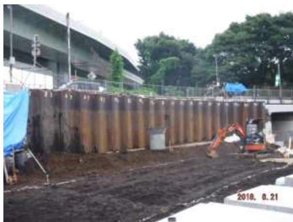
写真 4-9 環境保全のための措置の実施状況（鋼矢板工法の採用）
