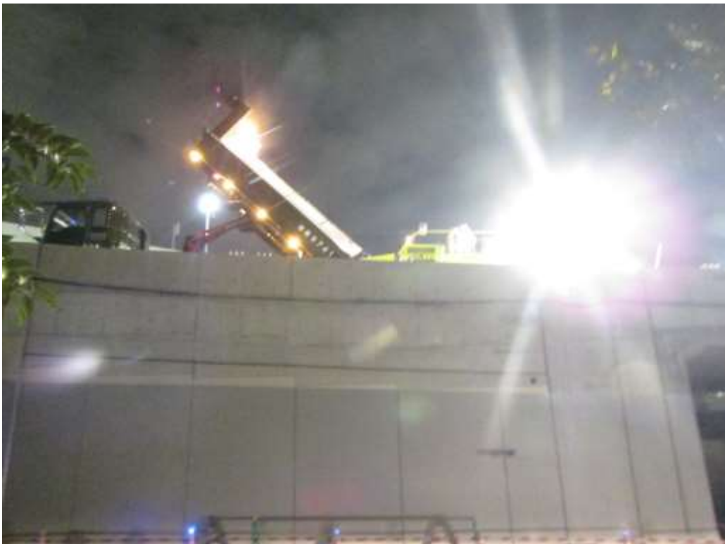
写真 2-1(2) No. 1 : 舗装工の工事状況(平成 31 年 2 月 13 日撮影)
