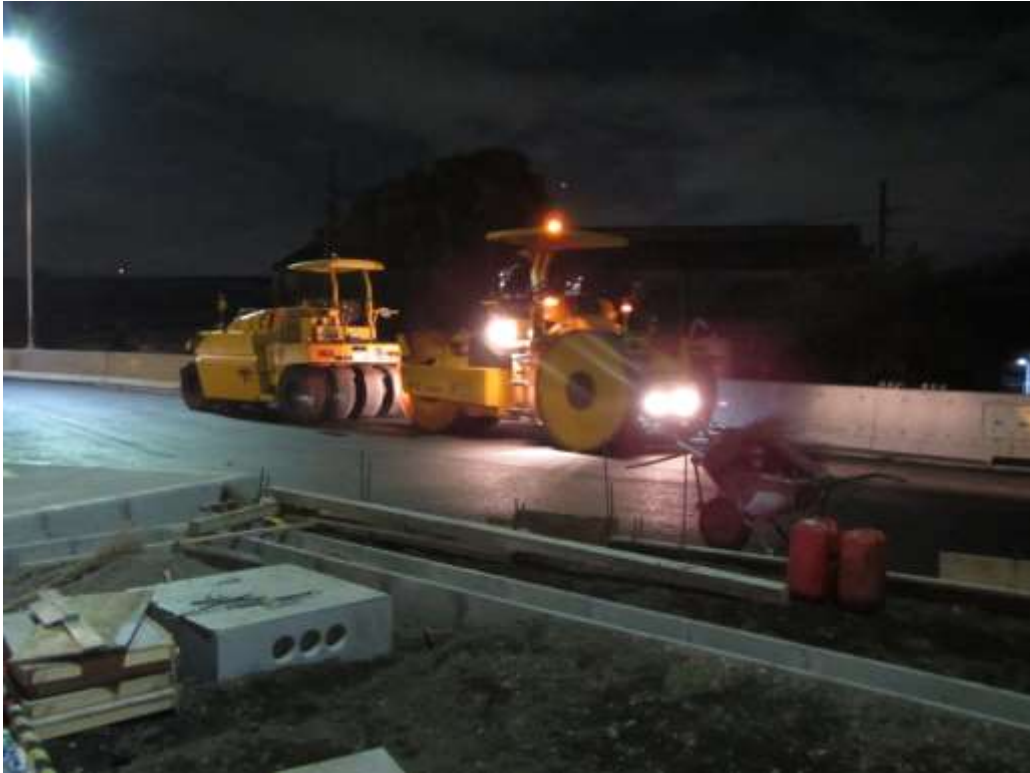
写真 2-1(1) No. 1 : 舗装工の工事状況(平成 31 年 2 月 12 日撮影)
