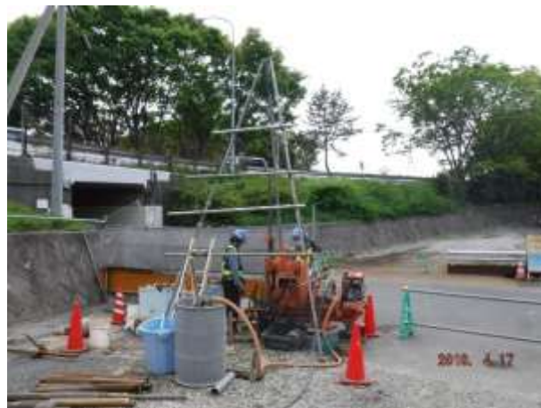
写真 4-8 環境保全のための措置の実施状況 （場所打ち杭の支持層確認のための地質調査）
