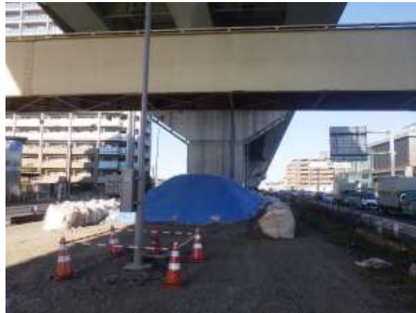
写真 4-1 環境保全のための措置の実施状況（飛散防止シート）
