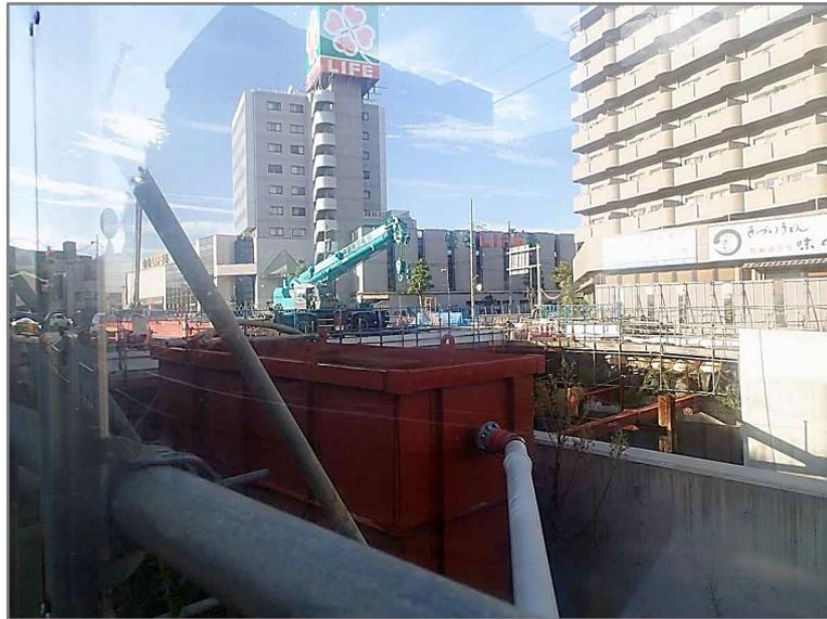
写真 4-2 沈殿槽
