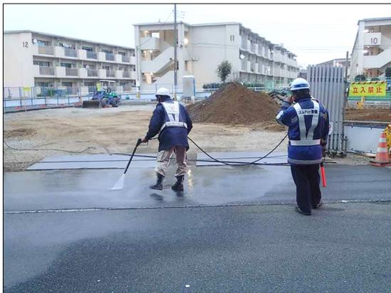
写真 4-1(3) 搬入・搬出路付近の仮舗装及び散水
