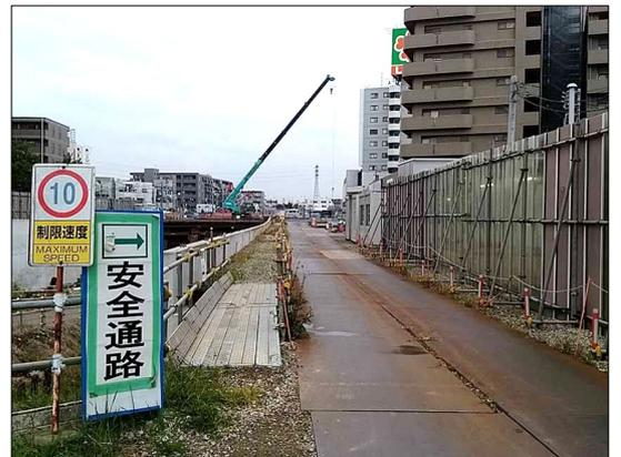
写真 4-1(4) 低速走行の表示及び敷鉄板の敷設
