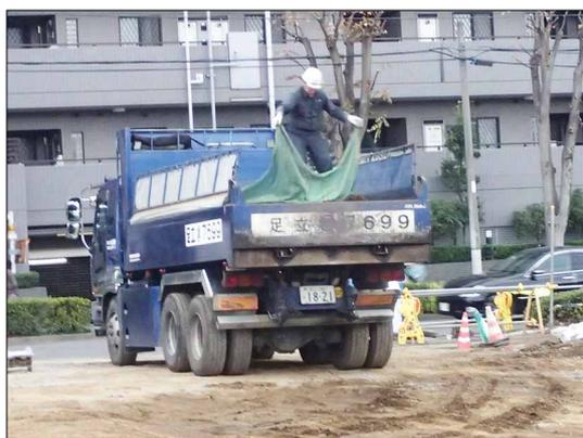
写真 4-1(7) 飛散防止シート設置状況
