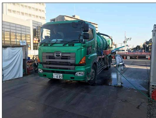
写真 4-1(8) 車輪の洗浄状況
