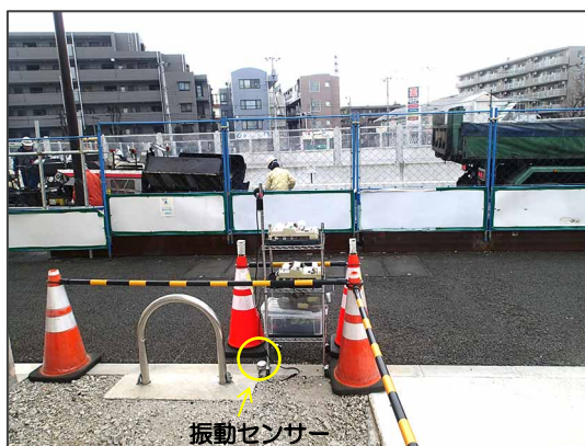
写真 2-1 (1) 振動測定状況 (No. 1 地点)
