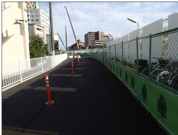
写真 1-3 仮囲い (高さ 3.0m) の設置状況
