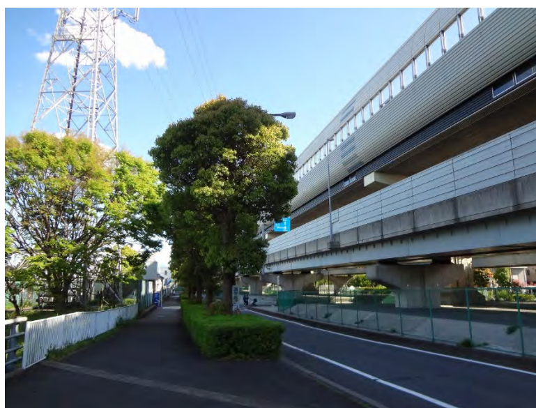
図6.1-1(1) 環境保全のための措置（遮音壁の設置）
