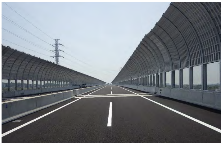
図6.1-1(4) 環境保全のための措置（高機能舗装の敷設）
