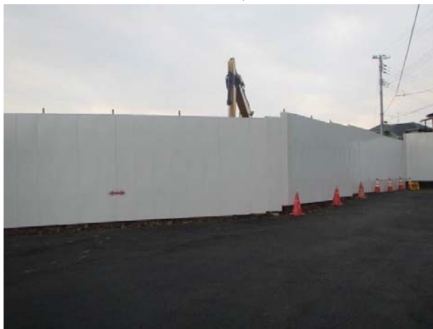
工事用遮音壁
