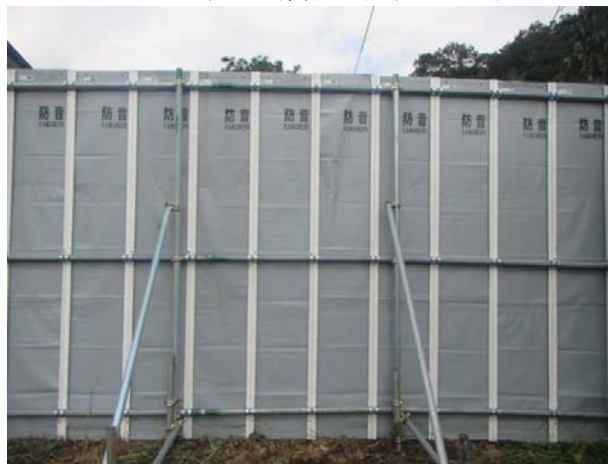
工事用遮音壁（裏面の防音シート）
