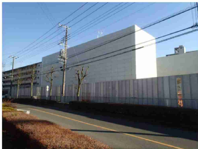
写真 1-3 除却建物の防音パネルの設置状況
