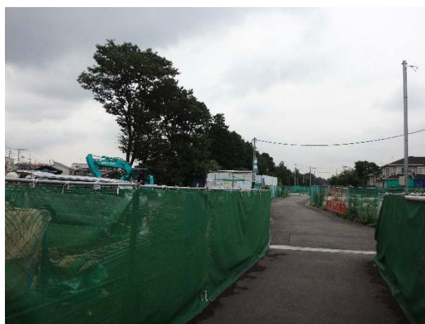
写真 6-4 ネットフェンスの設置状況
