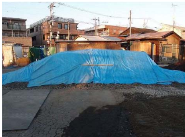
写真 6-1 防塵シートで覆う対策
