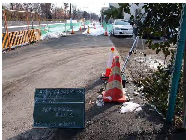
写真 1-5 歩道用地の一部を地先道路として暫定的に供用している箇所 (NO. 2、4、8)
