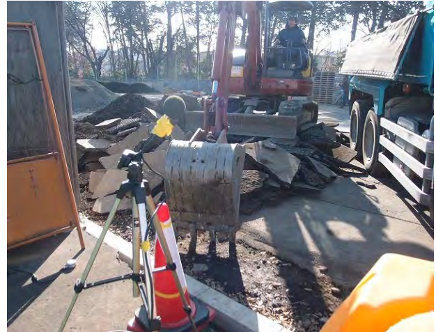
写真 1-4 舗装版のダンプトラックへの積み込み状況
