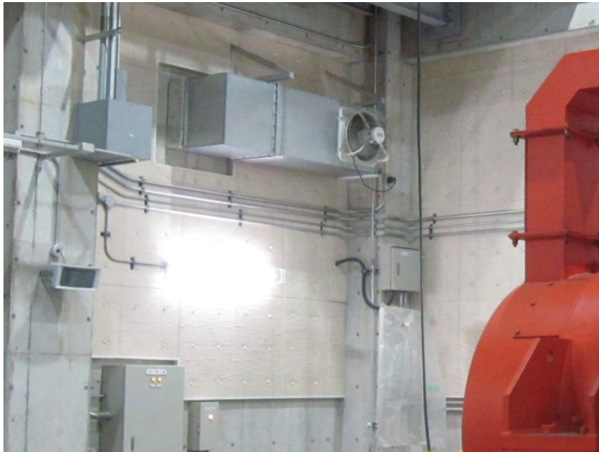
写真6-5(2) 吸音材・防音壁の設置状況（タービン発電機室）
