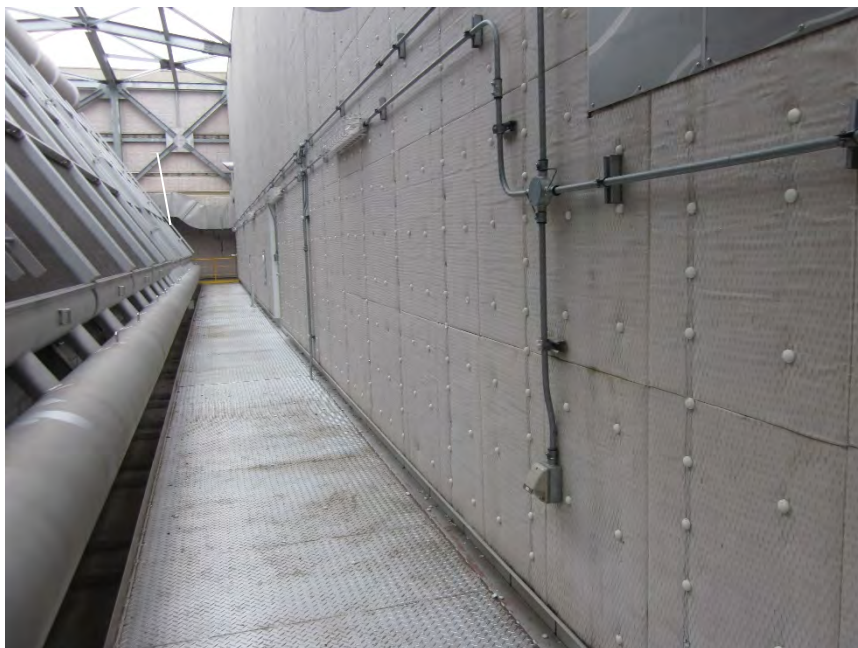
写真6-6 防音ケーシングの設置状況（蒸気復水器）
