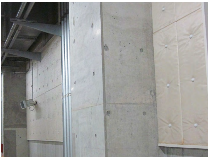
写真6-5(1) 吸音材・防音壁の設置状況（ボイラ補機室）
