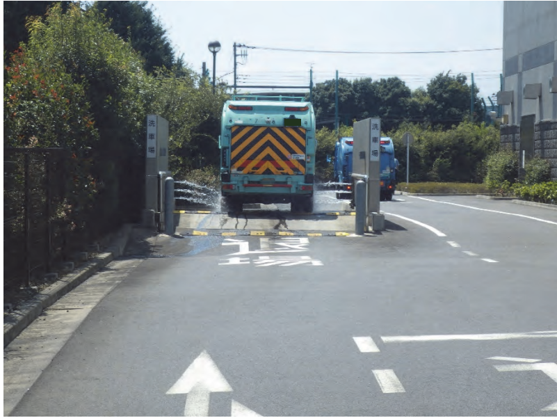
写真6-4 敷地内の洗車装置
