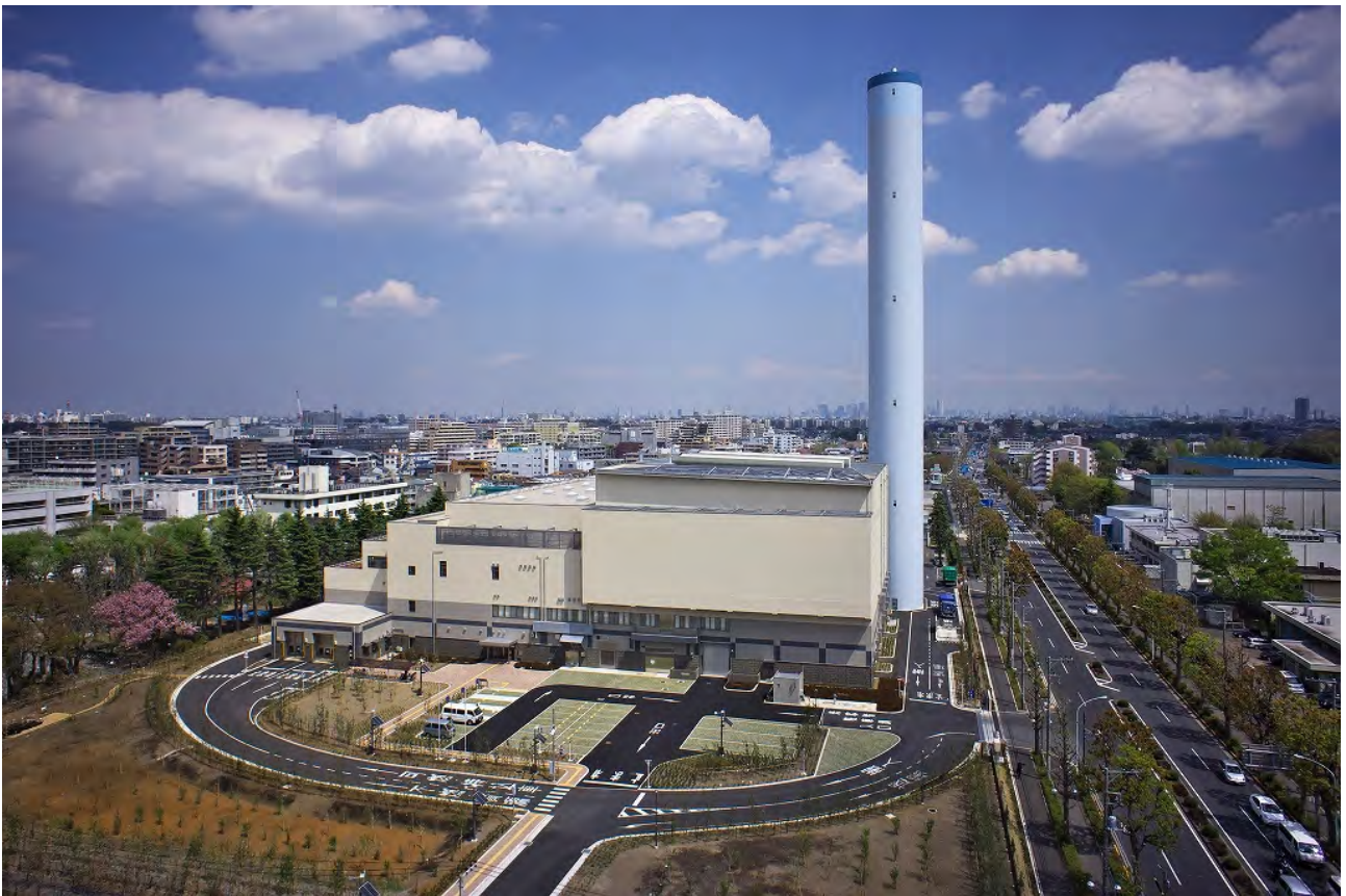
図5-2 本施設の全景写真（西南西側）
