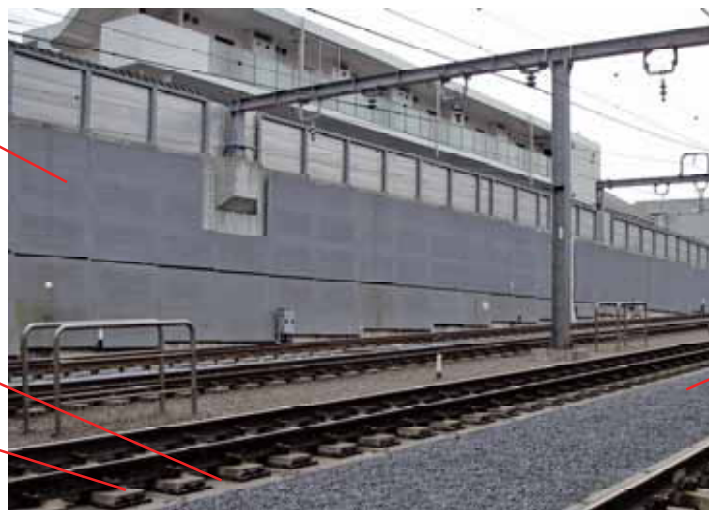
写真 6.1-1 弾性直結軌道、消音バラスト及び吸音パネルの設置状況
