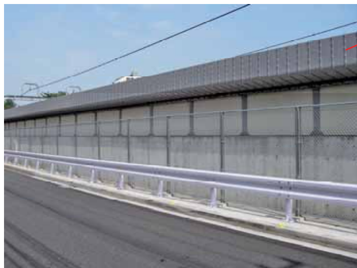
写真 6.1-2 干渉型防音装置を取り付けた防音壁
