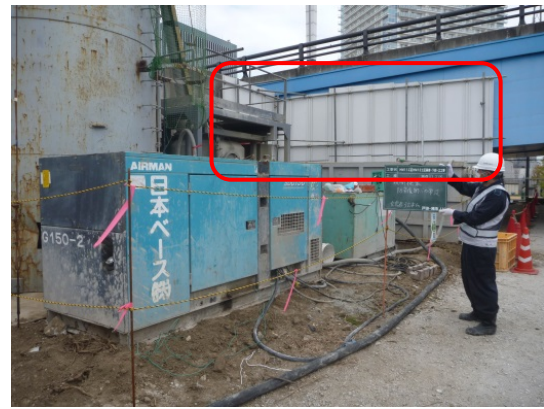
写真 3-22 環境保全のための措置の実施状況 (仮囲いの設置)
