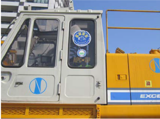
写真 3-13 環境保全のための措置の実施状況 (低騒音型建設機械)
