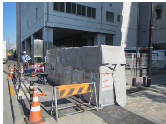
写真 3-18 環境保全のための措置の実施状況 (吸音パネルの設置)
