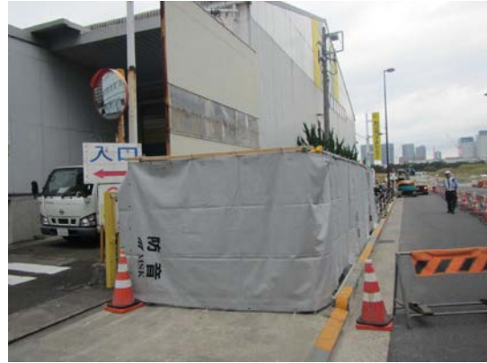
写真 3-20 環境保全のための措置の実施状況 (防音シートの設置)
