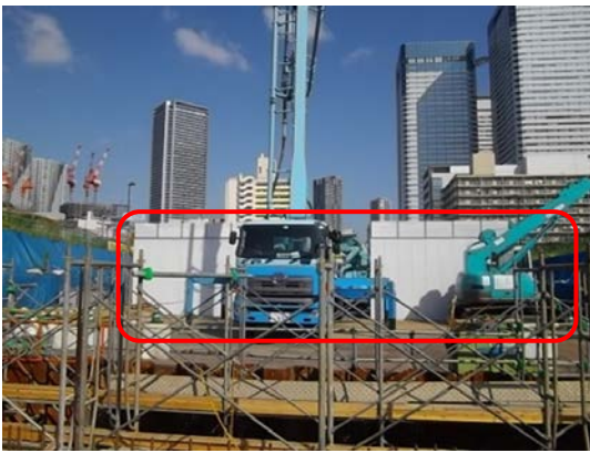
写真 3-21 環境保全のための措置の実施状況 (仮囲いの設置)
