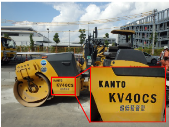
写真 3-15 環境保全のための措置の実施状況 (超低騒音型建設機械)
