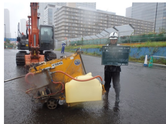
写真 3-24 環境保全のための措置の実施状況 (舗装カッターへの防音カバーの設置)
