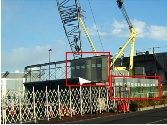
写真 3-19 環境保全のための措置の実施状況 (吸音パネルの設置)
