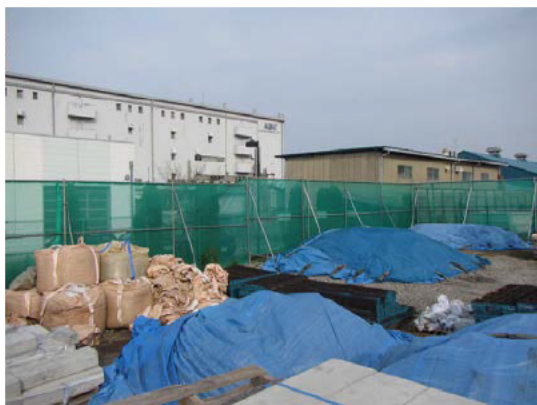
写真 3-3 環境保全のための措置の実施状況 (飛散防止シート)
