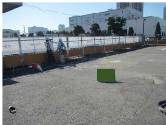
写真 3-6 環境保全のための措置の実施状況 (仮囲い)
