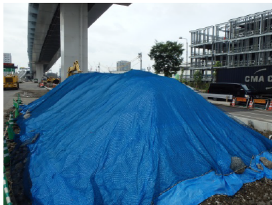
写真 3-4 環境保全のための措置の実施状況 (飛散防止シート)
