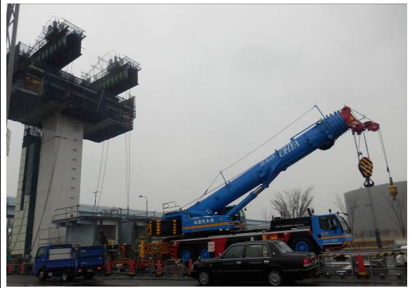
写真 C-2 トラッククレーン
