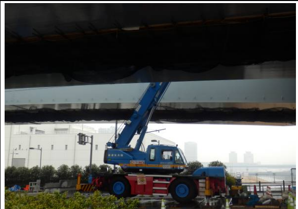
写真 C-4 ラフタークレーン
