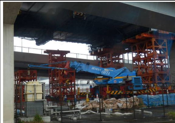
写真 C-3 ラフタークレーン
