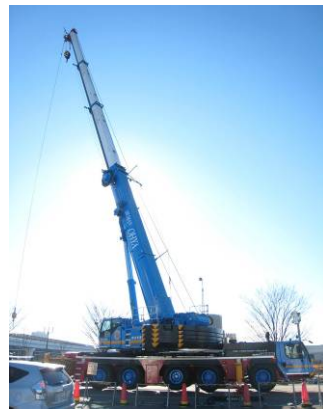
写真 B-4 トラッククレーン
