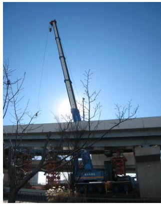
写真 B-5 トラッククレーン
