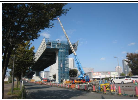
写真 A-2 トラッククレーン
