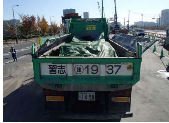
写真 1-2 環境保全のための措置の実施状況 (ダンプトラックによる汚染土壌運搬時の飛散防止対策)
