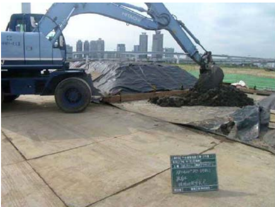
写真 1-3 環境保全のための措置の実施状況 (仮置き時の分離保管)
