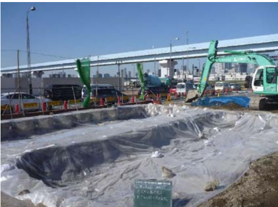
写真 1-5 環境保全のための措置の実施状況 (飛散防止対策)
