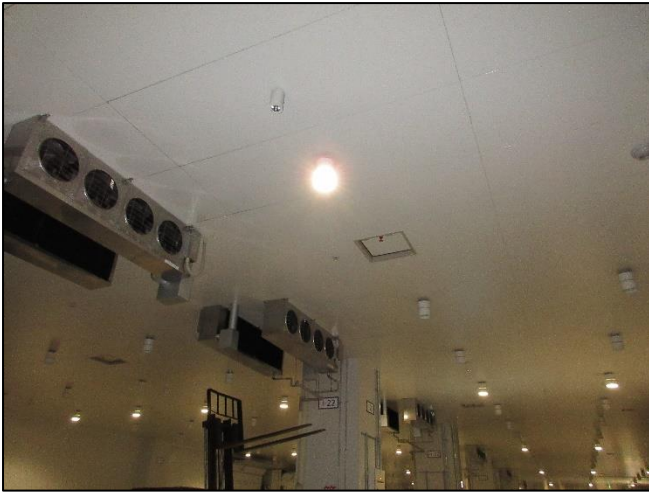
写真 6.8-4 LED の導入、蛍光灯の間引き運用
