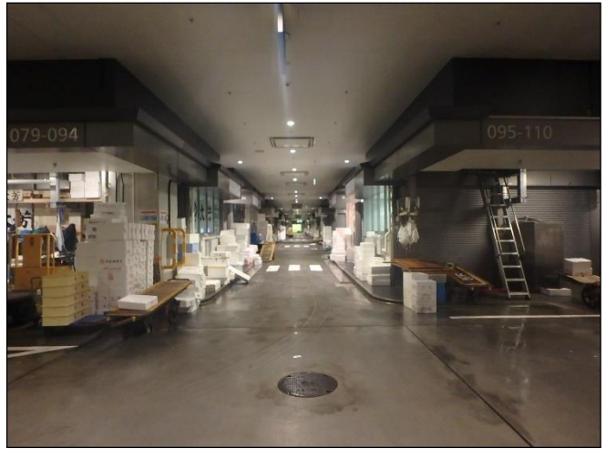
写真 6.8-4 LED の導入、蛍光灯の間引き運用
