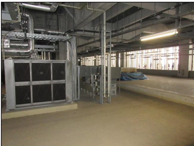
写真 6.8-6 外気冷房システムの活用状況
