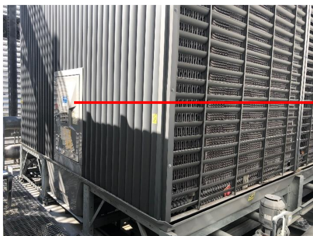
写真 6. 3-2 屋外に配置した低騒音型の冷却塔
