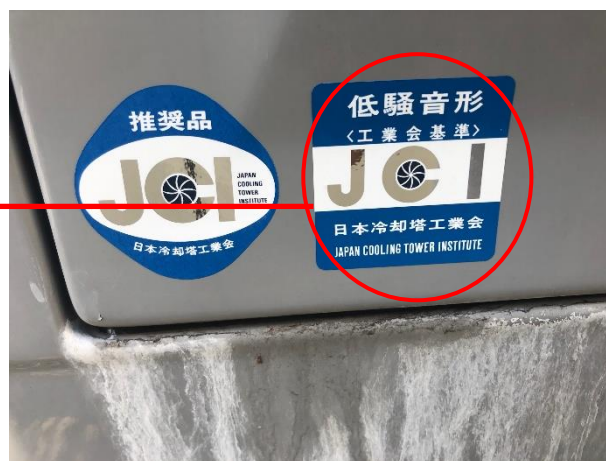
写真 6. 3-2 屋外に配置した低騒音型の冷却塔
