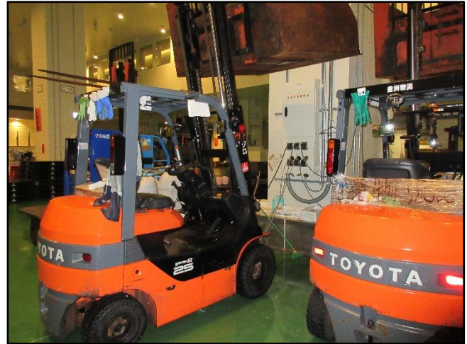
写真 6.1-6 ターレ、フォークリフト用の電源設備
