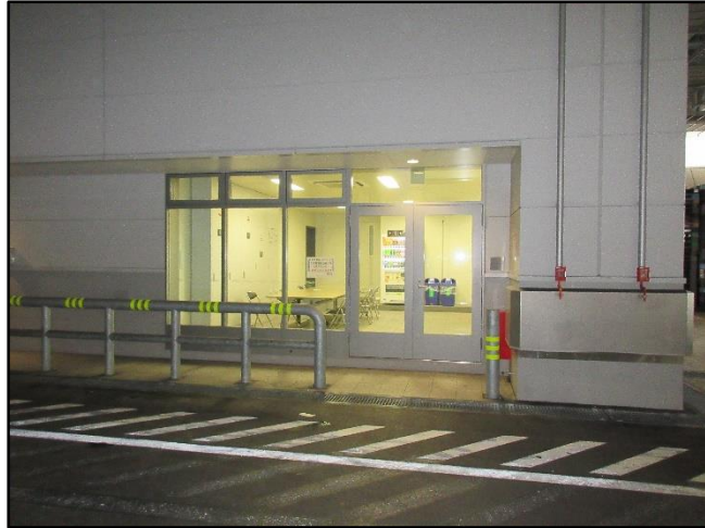
写真 6.1-8 運転者待機所の整備
