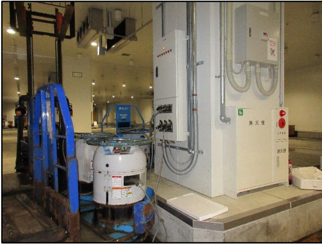
写真 6.1-6 ターレ、フォークリフト用の電源設備
