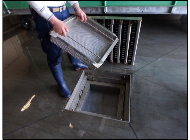
写真 6. 2-4 清掃が容易な構造（排水溝）
