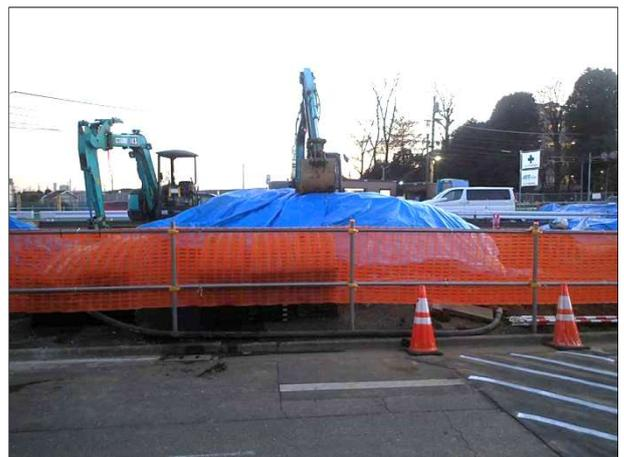
写真 4-1 (4) 土砂飛散防止シートの敷設
