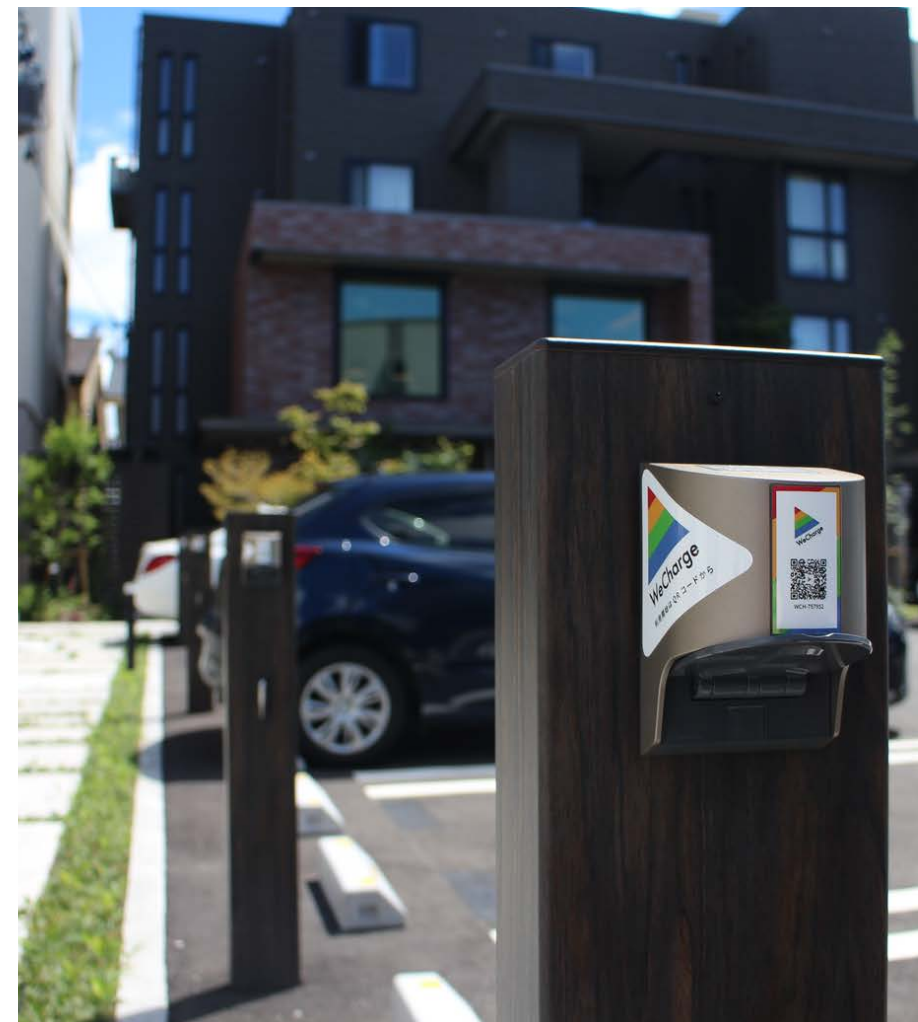
景観に配慮した木目調のポールの左右にEV充電コンセント設置
