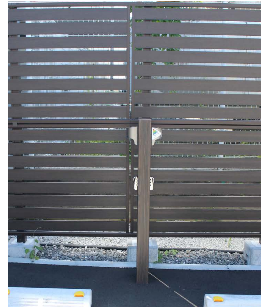
景観に配慮した木目調のポールの左右にEV充電コンセント設置
