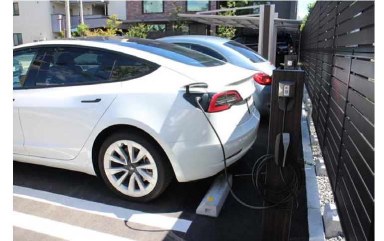
景観に配慮した木目調のポールの左右にEV充電コンセント設置
