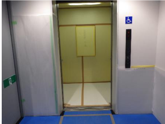
エレベーター内養生
