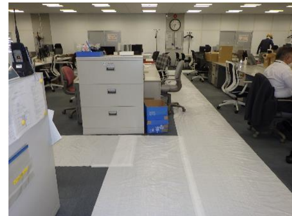
室内通路養生
