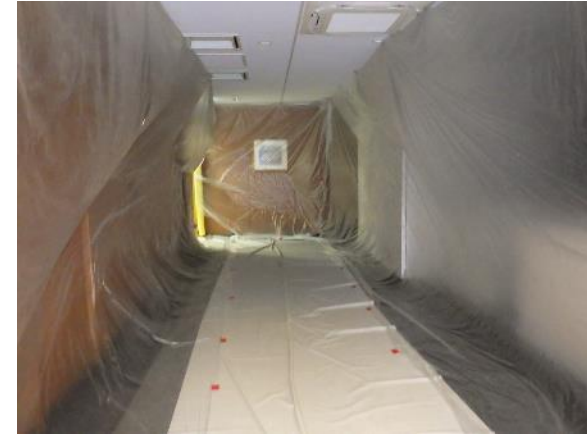
搬入通路養生
