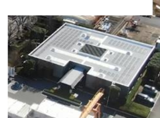
屋根太陽光パネル
