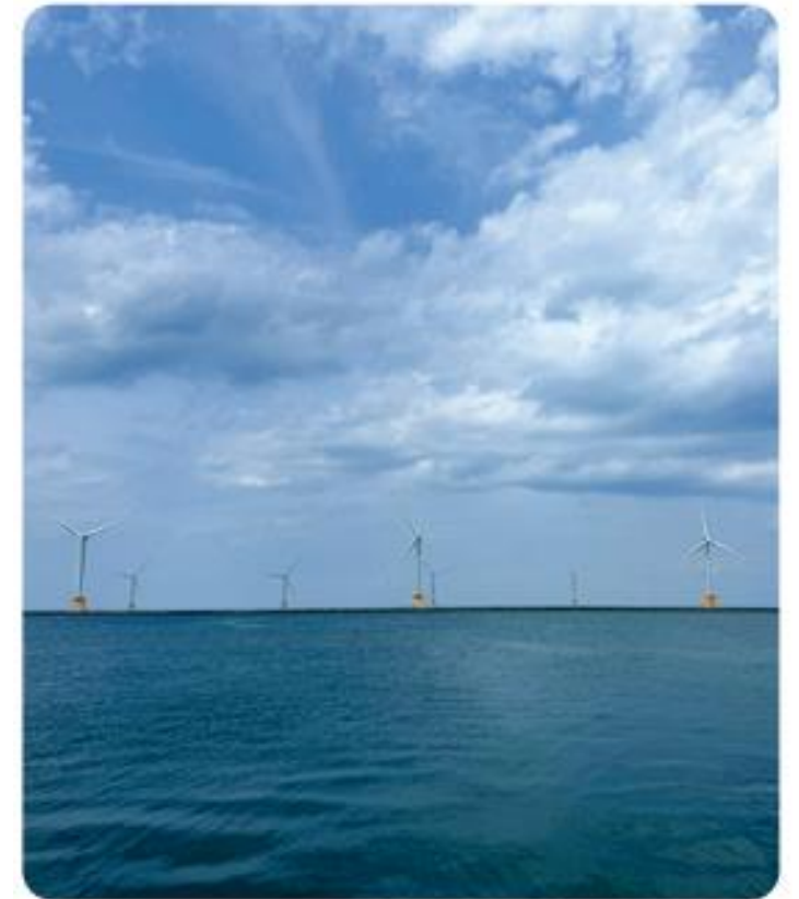
石狩で稼働している洋上風力発電
