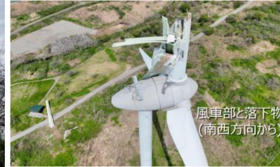
〈事故が発生した風車と、落下したブレードの様子〉
