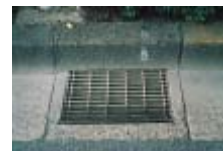
雨水ます (グレーチング)
