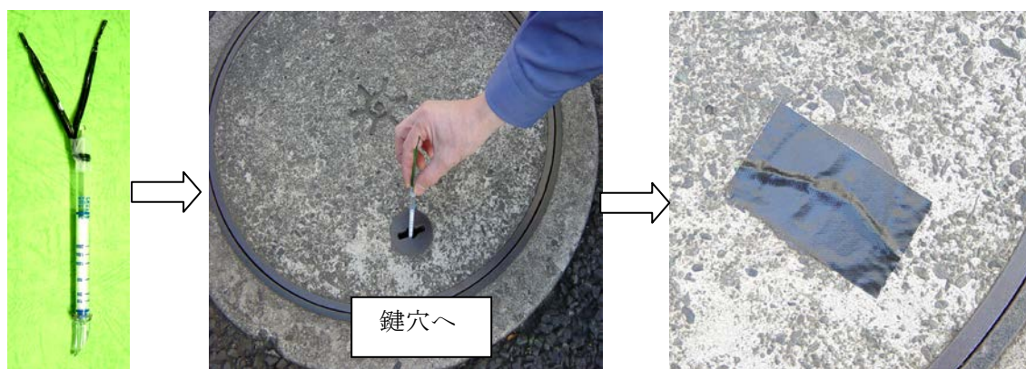
写真 5 設置方法（黒テープで固定した例）
