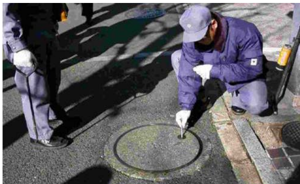
写真 2 長時間用検知管による硫化水素濃度測定
