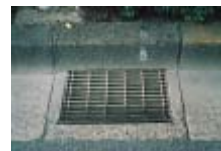
雨水ます (グレーチング)
