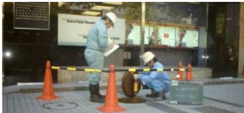
写真 3 硫化水素連続測定器による硫化水素濃度測定
