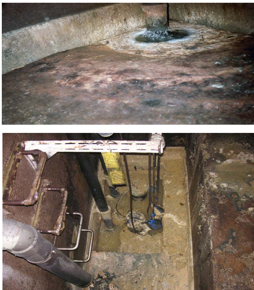
写真 4 清掃前のビルピット
