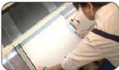
ショーケースの床板をはずします。
