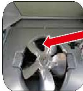
写真 4.4 ファンの隙間から熱交換器の油にじみ霜付を確認
