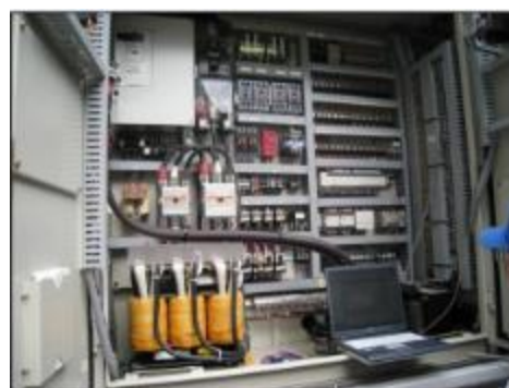
写真 8.5 制御ソフト点検の状況
