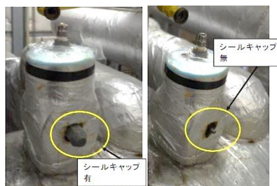
写真 8.19 安全弁の止め弁シールキャップ (有:左図 無:右図)
