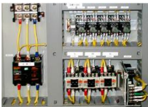
写真 3.24 左：電源盤内（ブレーカー・電磁開閉器等） 右：制御盤表示ランプ等
