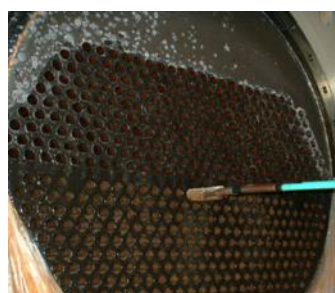
写真 3.18 熱交換器洗浄例 (左:高圧洗浄 右:チューブブラシ洗浄)
