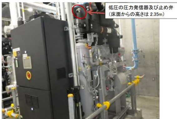
写真 8.8 冷凍設備の全体図
