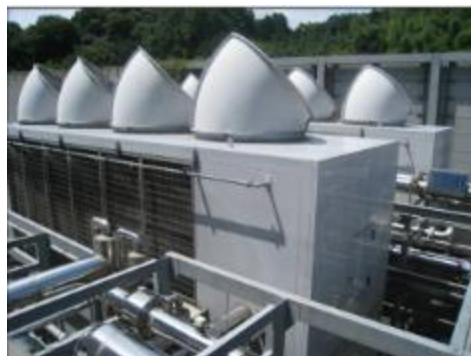
写真 8.3 機器の設置状況
