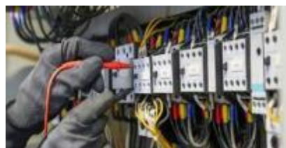
写真 3.10 電圧測定方法
