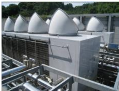
写真 8.3 機器の設置状況
