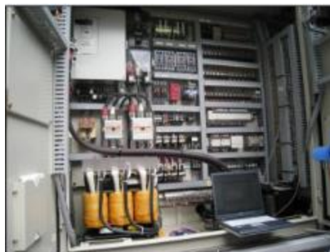
写真 8.5 制御ソフト点検の状況
