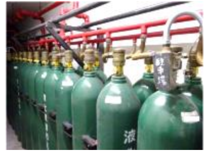
写真 8.25 容器弁(付属品)に設置されたコントロールヘッド(ソレノイド式)
