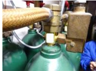
写真 8.26 コントロールヘッド(ソレノイド式)と容器弁(付属品)
