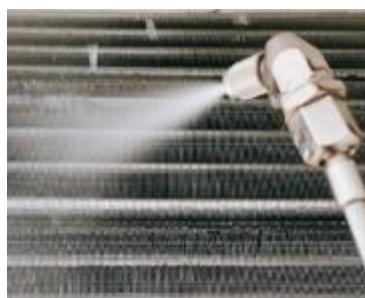
写真 3.18 熱交換器洗浄例 (左:高圧洗浄 右:チューブブラシ洗浄)
