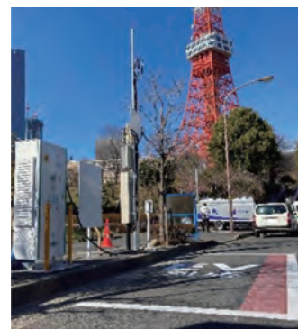
公道（パーキングメーター設置エリア） の充電設備の設置
