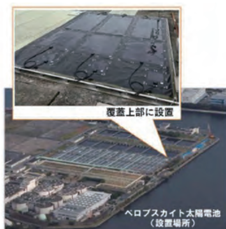
森ヶ崎水再生センター
