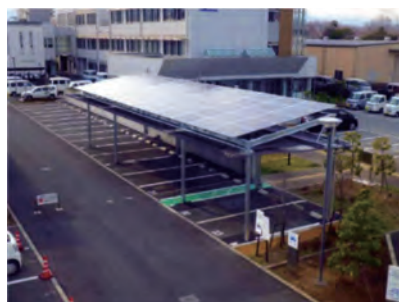
ソーラーカーポート (八王子給水事務所)
