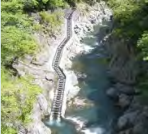
多摩川の白丸ダムの上下流を接続する魚道 63
